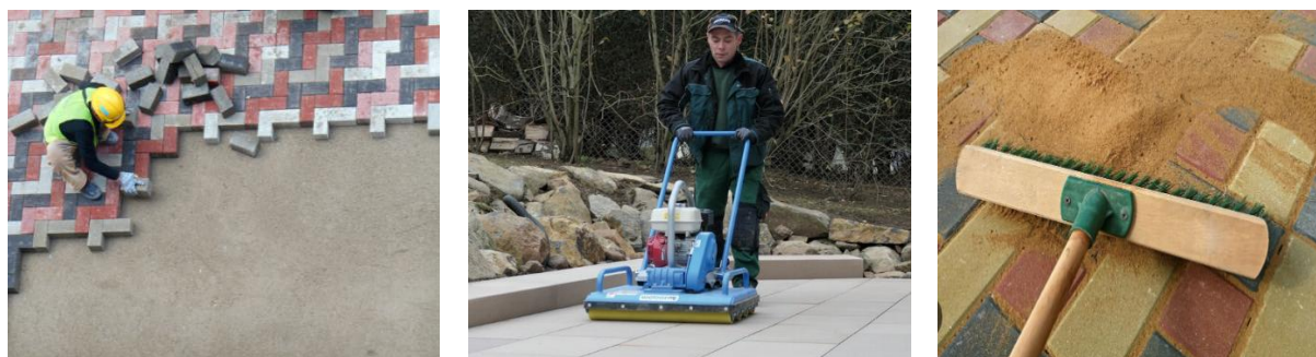
Fig. 26. Așezarea, compactarea pavelelor și umplerea rosturilor
