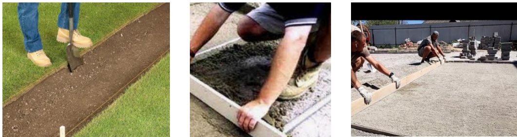
Fig. 18. Lucrări de nivelare a terenului
