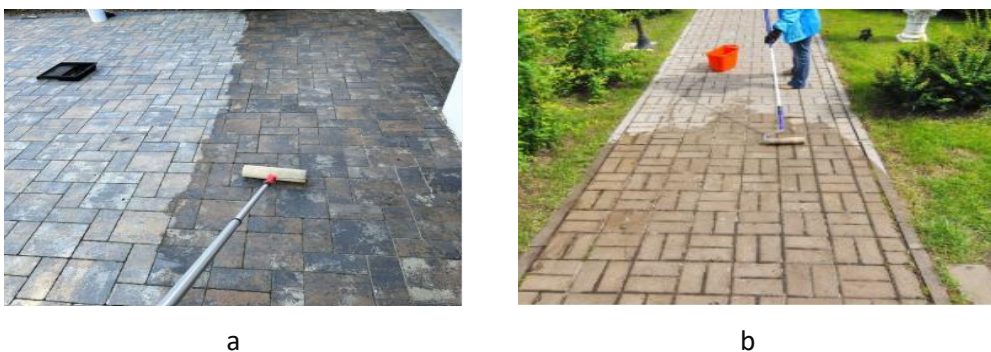
Fig. 32. Aplicarea lacului pentru pavaj (a); aplicarea vopselei impermeabile (b)
