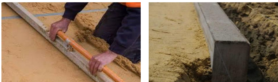
Fig. 24. Pregătirea patului de nisip
