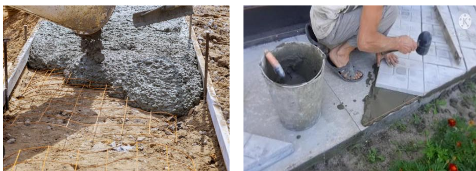
Fig. 27. Montarea pavelelor pe beton
