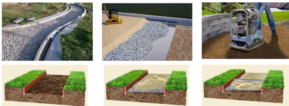
Fig. 19. Pregătirea stratului de suport pentru montarea pavajului
