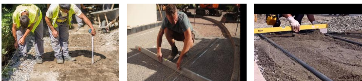
Fig. 14. Marcarea limitelor pavajului
