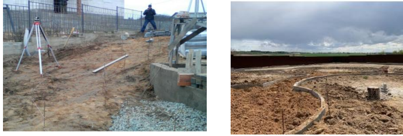
Fig. 16. Identificarea și marcarea zonelor pentru pavaj
