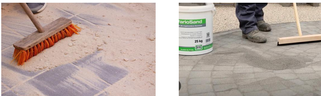
Fig. 30. Aplicarea nisipului și a nisipului cu ciment pentru rosturi
