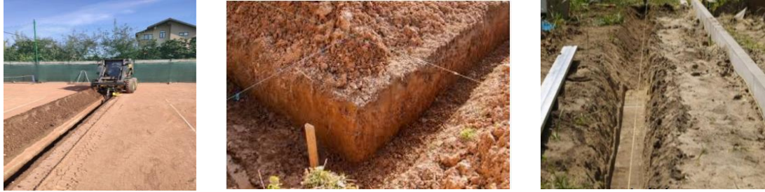
Fig. 20. Pregătirea șanțului pentru montarea bordurilor
