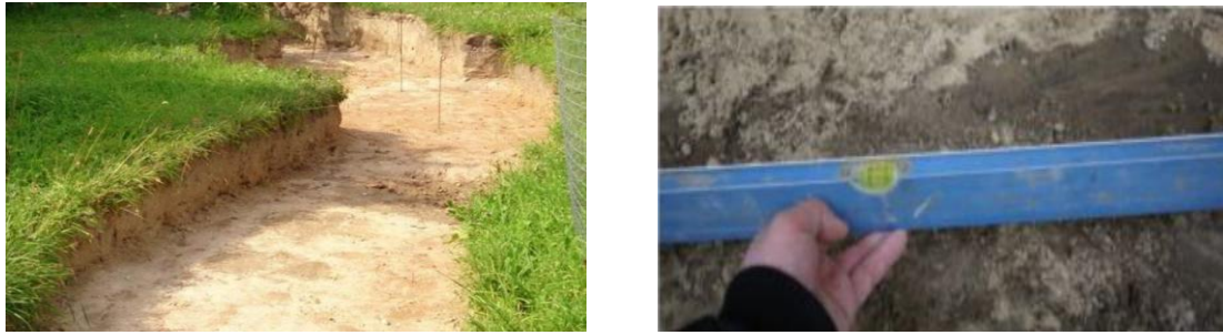
Fig. 17. Pregătirea terenului pentru executarea lucrărilor de pavaj
