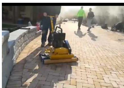
Fig. 29. Compactarea pavelor
