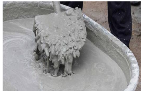
Fig. 11. Pregătirea manuală a mortarului
