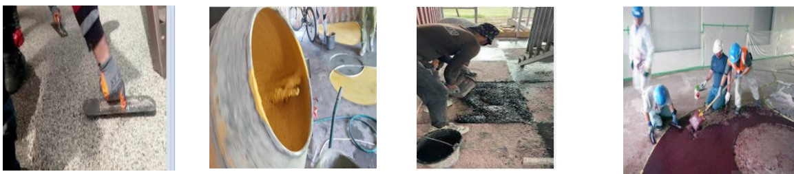
Fig. 15. Turnarea mortarului
