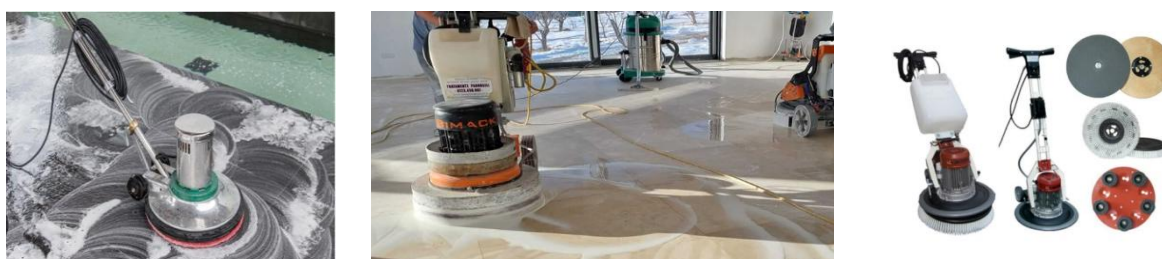
Fig. 20. Șlefuirea umedă a suprafețelor mozaicate
