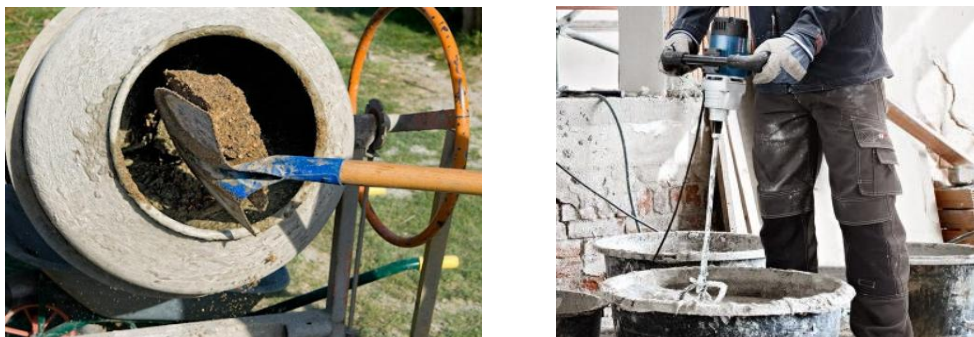
Fig. 12. Pregătirea mecanizată a mortarului
