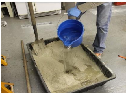
Fig. 11. Pregătirea manuală a mortarului
