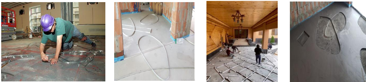
Fig. 14. Șablonarea și pregătirea suprafețelor
