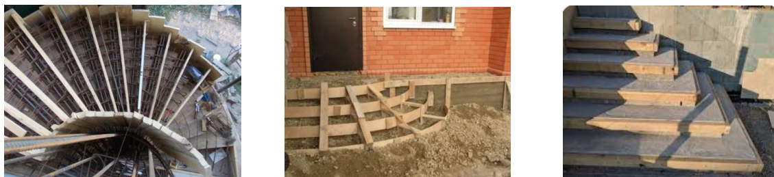
Fig. 17. Montarea cofrajelor
